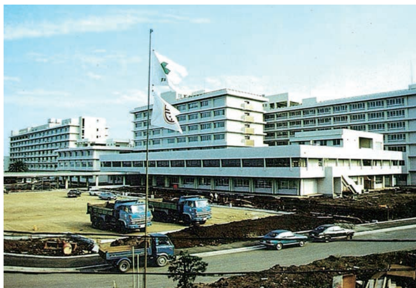
昭和 51 年 12 月 附属病院棟周辺環境工事 (大学 HP より)
