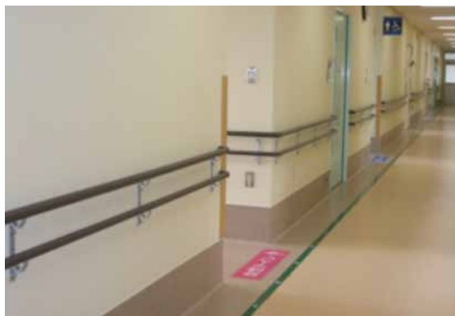
写真1 廊下の手すり
